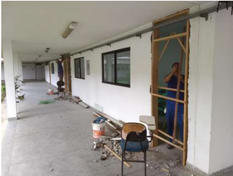
Substituição das portas e caixas de porta das salas do Mestrado
