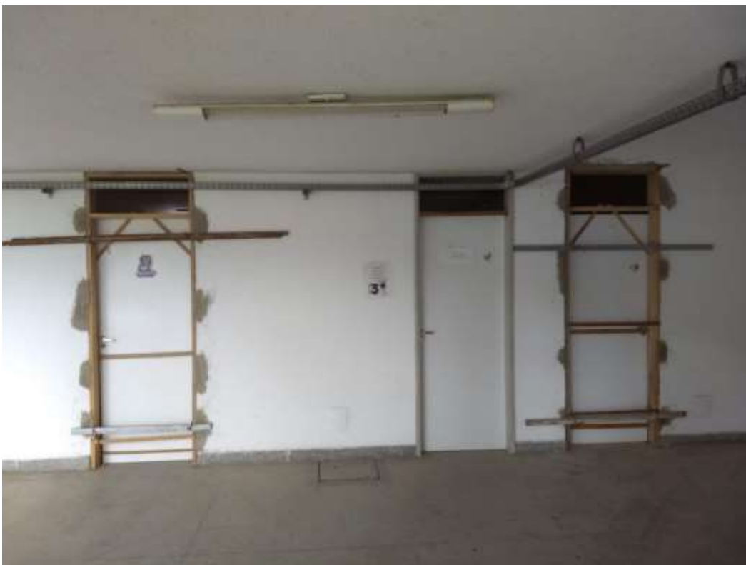
Substituição de portas na parte nova da FDA (Atlética e Biblioteca)
