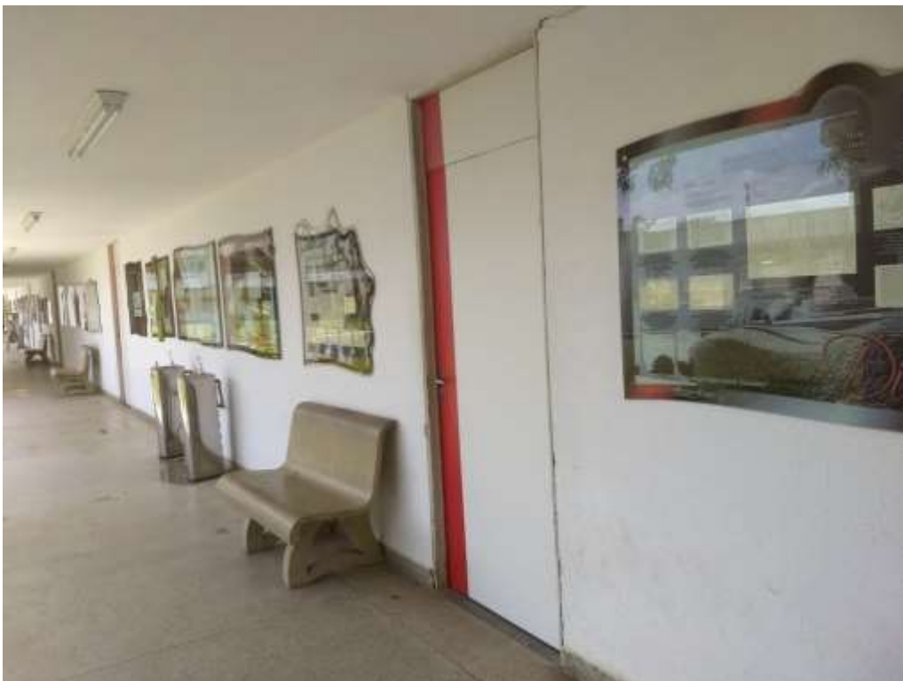
Porta substituída em sala de aula da Graduação
