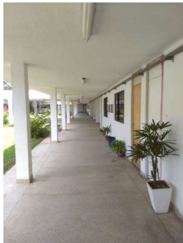
Substituição de portas das salas de aula da FDA
