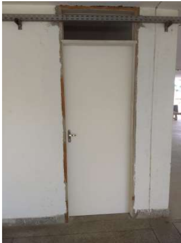
Porta substituída na sala do Mestrado
