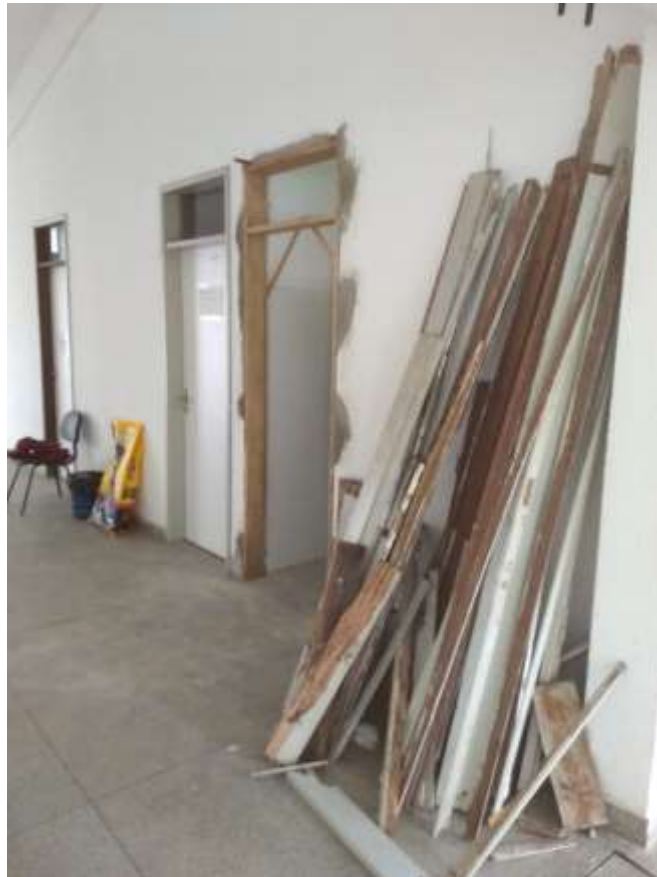
Substituição de portas na parte nova da FDA
