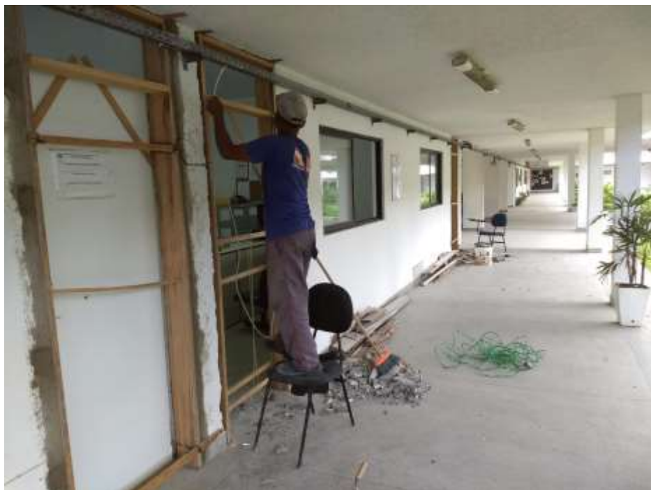
Substituição de portas na parte nova da FDA
